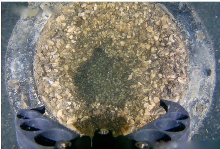
(1) Bewuchs in einer Seeleitung nach der Demontage des Seihers.
