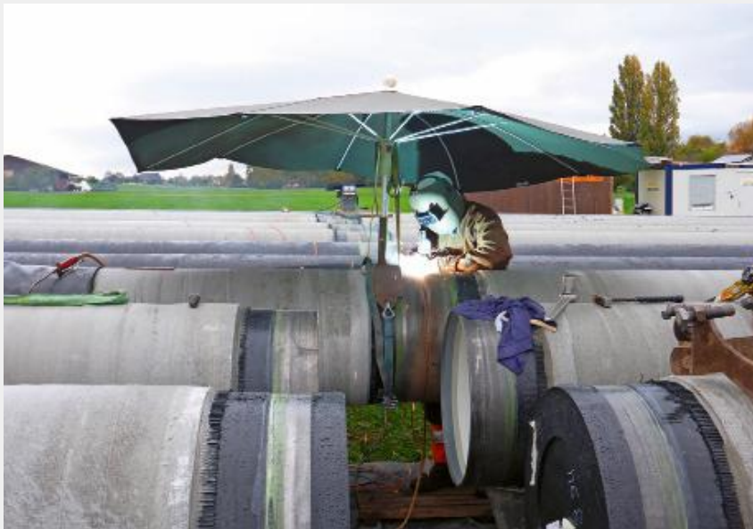
Fig. 2 Schweissarbeiten am Rohrstrang für grabenlosen Leitungsbau.
