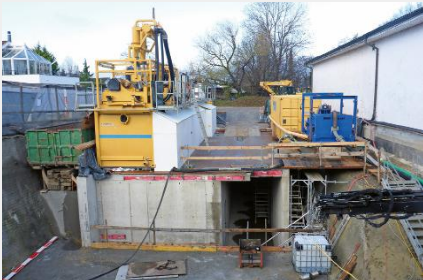
Fig. 4 Weitere Einrichtungen für die Bohrarbeiten.
