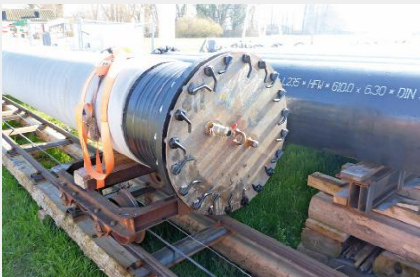
Fig. 6 512-m-Rohrstrang auf der Einwässerungsbahn.
