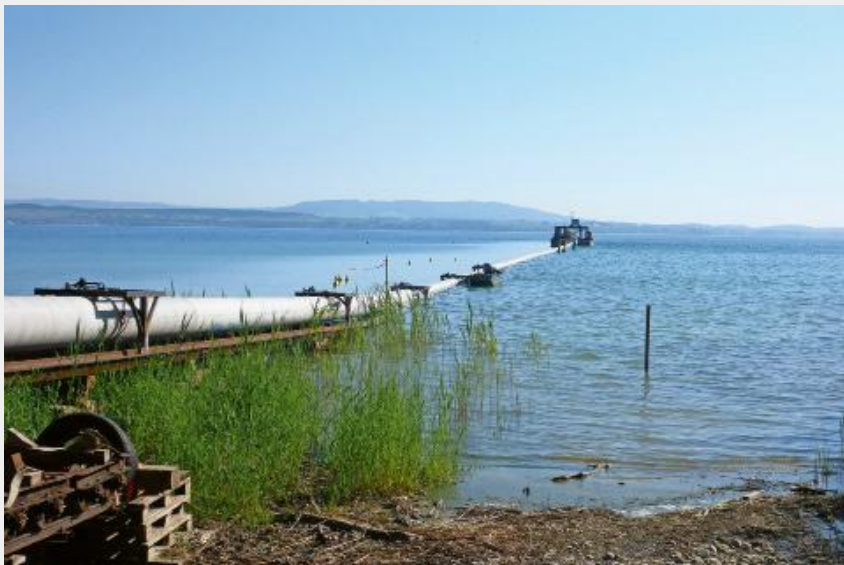
Fig. 7 512-m-Rohrstrang beim Einwassern.
