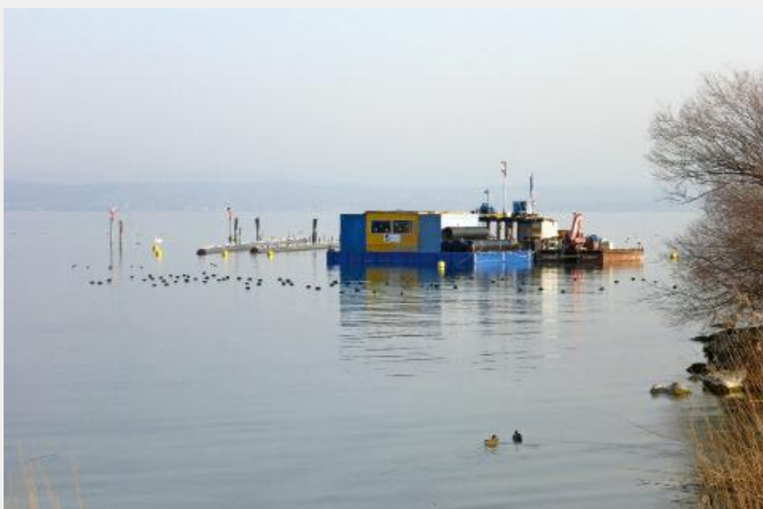
Fig. 9 Pontoneinheiten neben dem schwimmenden Rohrlager.
