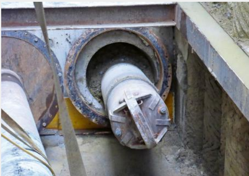
Fig. 8 Zugkopf nach dem Austritt aus der Bohrhöhle in der Baugrube.
