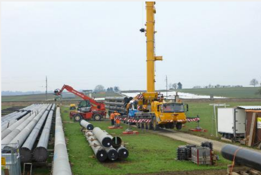
Fig. 1 Rohrlager und Rohrschweisplatz in Güttingen.
